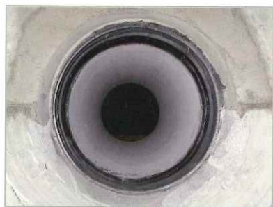
写真-1 耐震ゴムリング設置後
