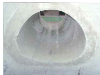
写真-6 自立管施工後
