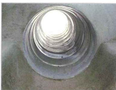
写真-2 複合管施工後
