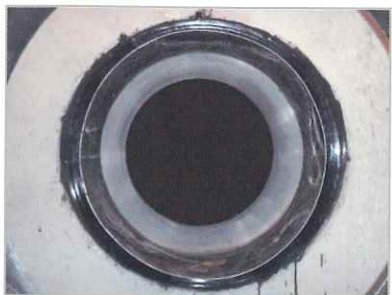
写真-4 耐震ゴムリング設置後
