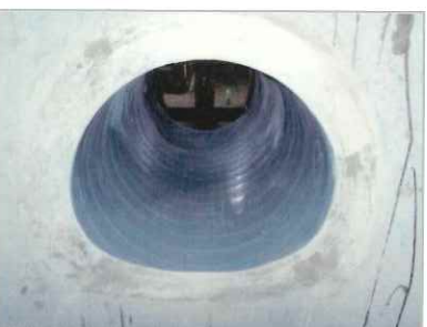
写真-5 複合管施工後
