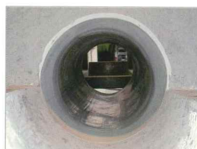
写真-3 自立管施工後
