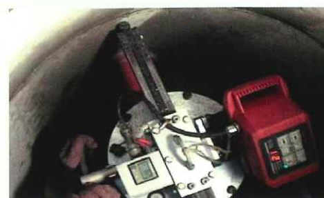
▲マンホール壁の削孔状況
