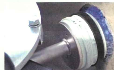
▲消散弁の圧入状況
