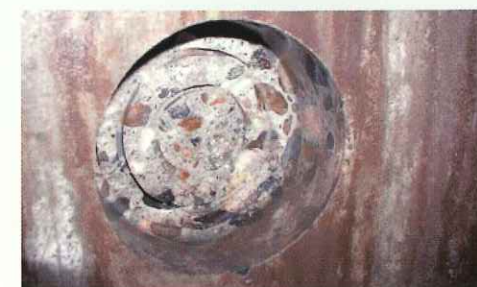
▲削孔完了状況
