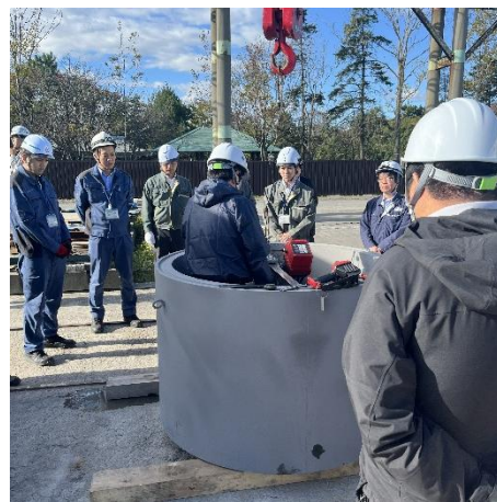
写真-4 組立マンホール側塊への消散弁設置のデモ施工
