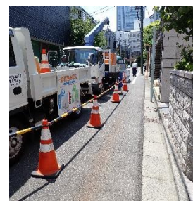
写真-9 作業帯設置状況
