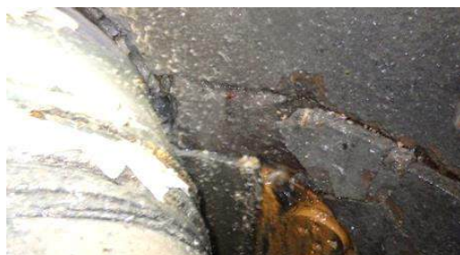
写真-2 躯体の水平断裂と管の突込み被害 写真-3 浮上無の確認状況 写真-4 道路側溝利用の地上仮配管
