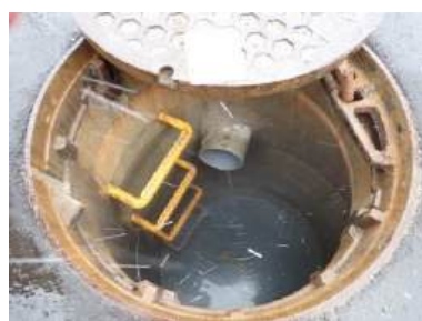
写真-5 金沢市 管きよ閉塞に伴う道路側溝利用の地上仮配管による圧送
