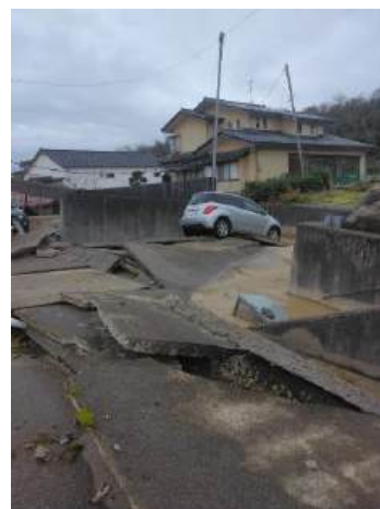
内灘町の側方流動の惨状
