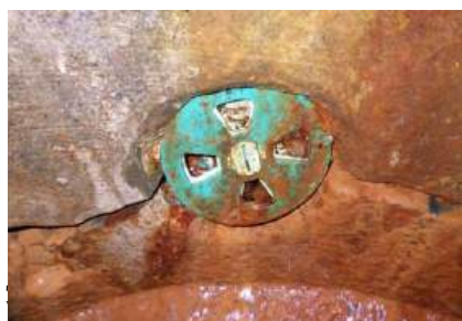
写真-5 消散弁を貫通しているマンホール躯体下部の水平断裂
