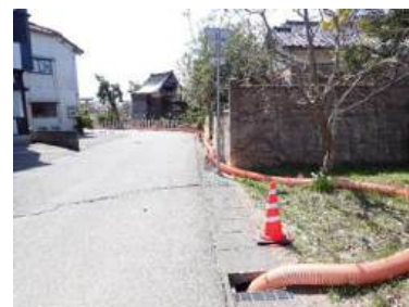
写真-2 躯体の水平断裂と管の突込み被害 写真-3 浮上無の確認状況 写真-4 道路側溝利用の地上仮配管
