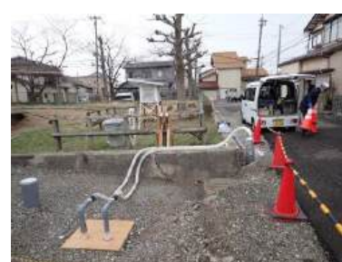
写真-5 金沢市 管きよ閉塞に伴う道路側溝利用の地上仮配管による圧送
