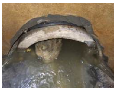
写真-6 耐震化されていないマンホールへの管の突込みとインバートの損傷
