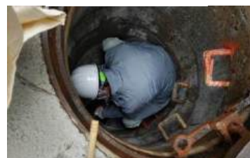
写真-2 出来形確認状況
