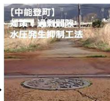
マンホールの浮上抑制対策
