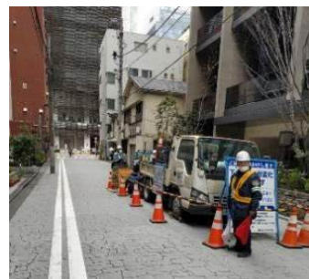
写真-1 作業状況
