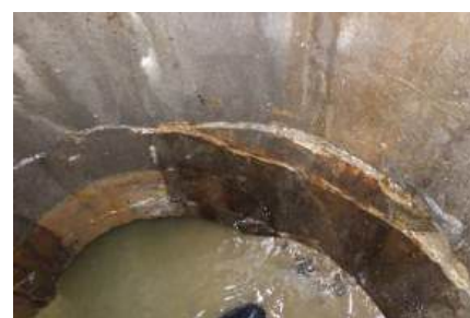
写真-7 マンホール躯体下部の水平断裂
