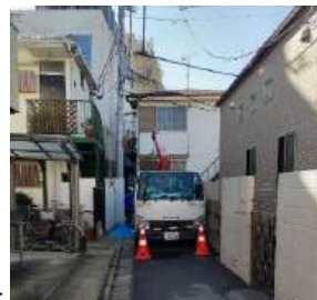
写真-6 狭小道路での施工
