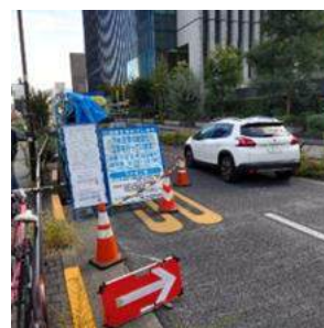
写真-5 作業帯の設置状況
