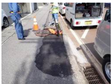
写真-4 金沢市 液状化による路面沈下補修と浮上なしの人孔
