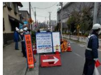
写真-3 作業状況
