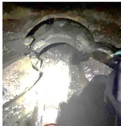
写真-1 管口の突出被害状況
