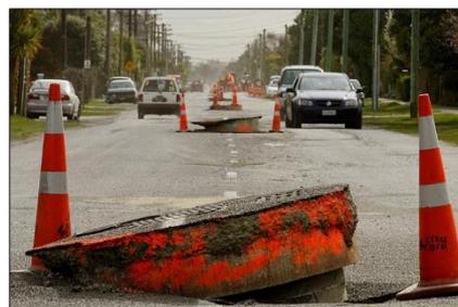
写真-8 クライストチャーチにおけるマンホール浮上被害
