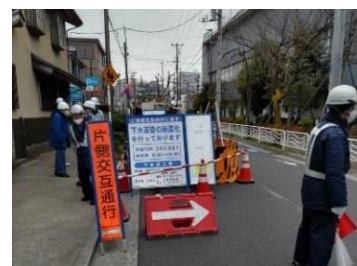
写真-3 作業状況
