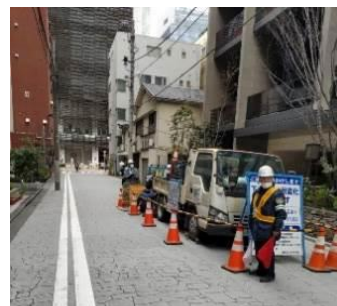
写真-1 作業状況
