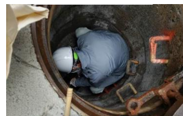
写真-2 出来形確認状況
