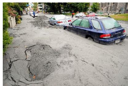
写真-7 クライストチャーチにおける大規模な液状化被害の様子
