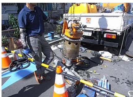
写真-5 江東区潮見一丁目切削機搬入作業
