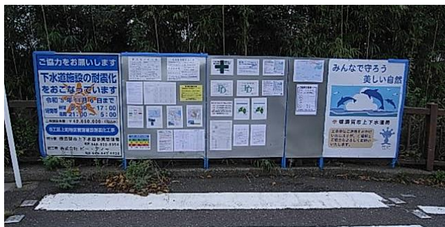
写真-2 横須賀市1か所にまとめられた工事案内
