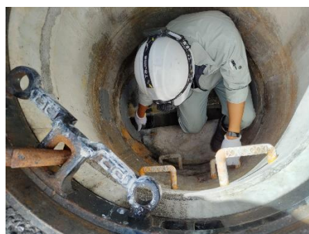
写真-4 江東区塩浜二丁目出来形の確認状況
