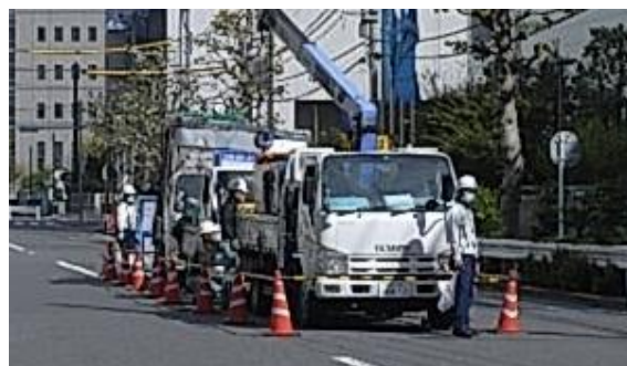
写真-3 江東区塩浜二丁目作業状況
