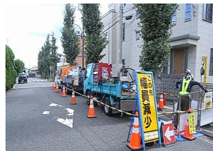
写真-1 横須賀市一発君施工現場
