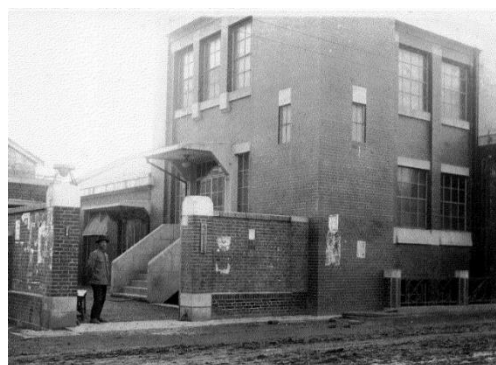
写真-1 建設当時の泉町ポンプ所
