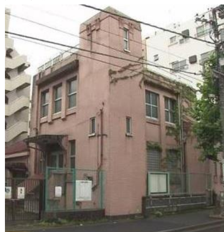
写真-2 解体前の泉町ポンプ場
