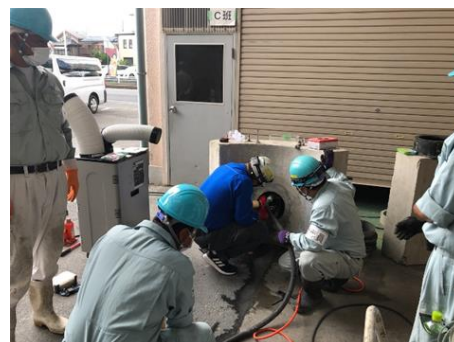
写真-2 一発くん施工実習の様子
