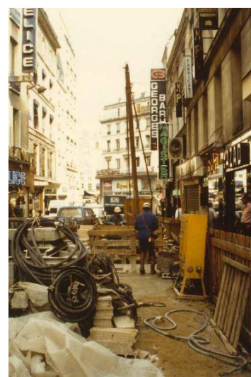
写真-2 更新工事の現場
