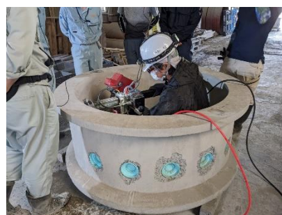
写真-4 フロートレス工法施工実習の様子
