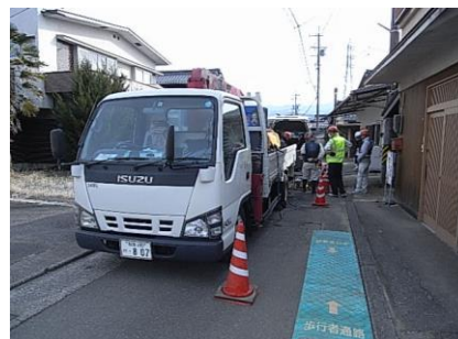
写真-1 飯田市での作業状況
