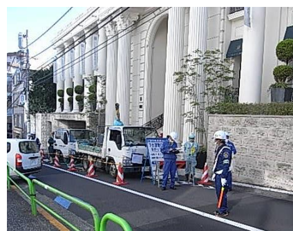
写真-2 南青山の作業状況
