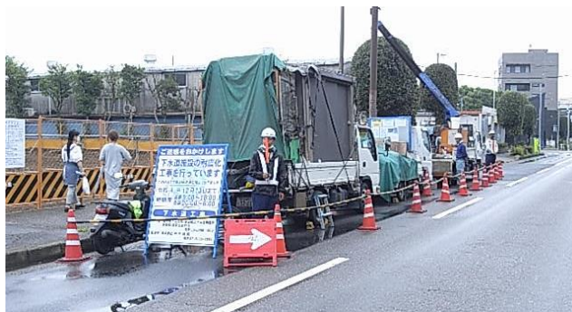
写真-4 足立区入谷の現場状況
