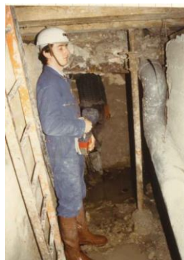
写真-7 工事中の接続管廊
