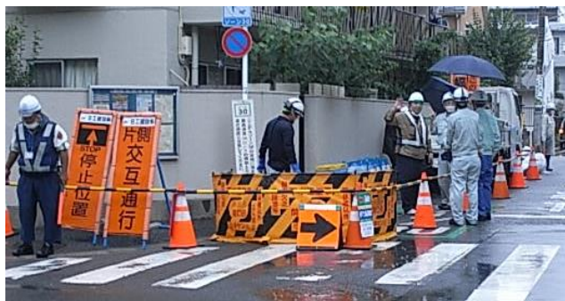
写真-3 中野区新井の現場状況
