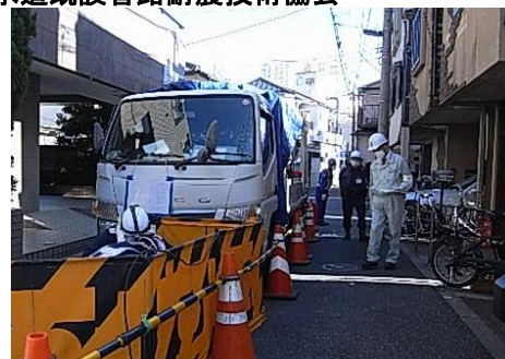
写真-3 千駄木の作業状況
