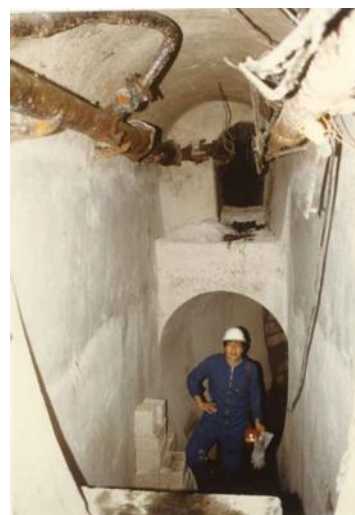
写真-1 新旧の下水道管
