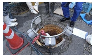
写真-3 ハスティーを用いた換気
