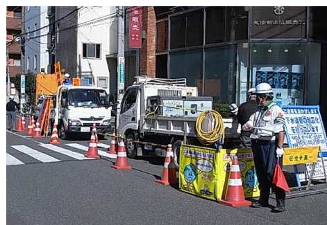
写真-4 徳丸の作業状況
