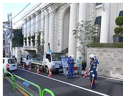
写真-2 南青山の作業状況
