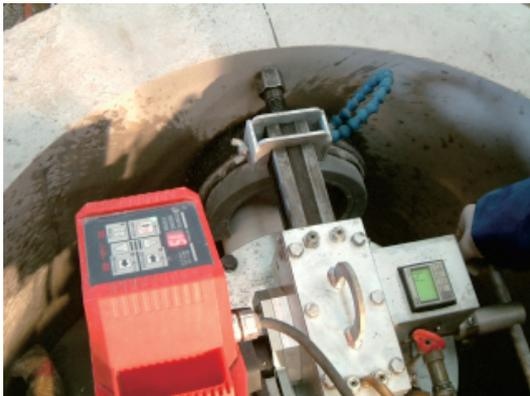
写真-2 消散弁取付け削孔状況
