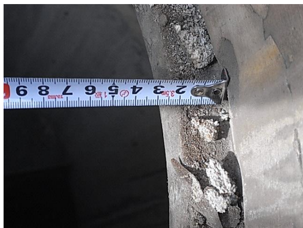
(写真-5) 側塊 3 cm のずれ
