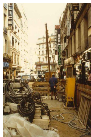
写真-2 更新工事の現場
