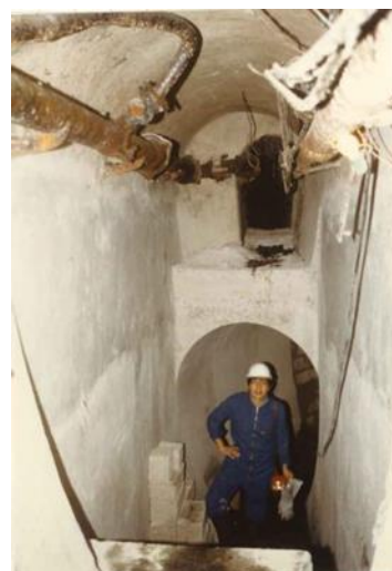
写真-1 新旧の下水道管
