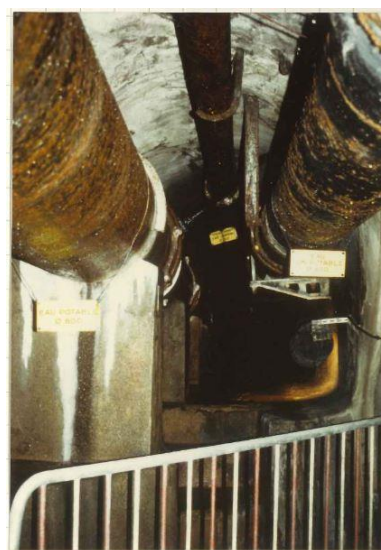
写真-3 下水管内に敷設された水道管類
