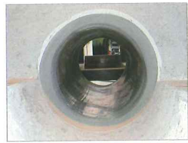
写真-3 自立管施工後
