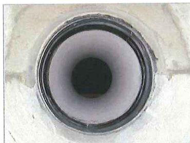
写真-1 耐震ゴムリング設置後
