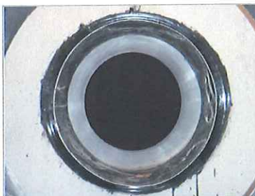
写真-4 耐震ゴムリング設置後
