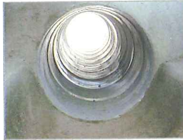
写真-2 複合管施工後
