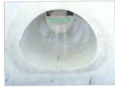
写真-6 自立管施工後
