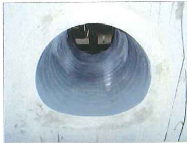
写真-5 複合管施工後
