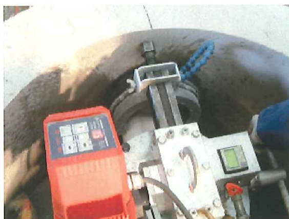
写真-2 消散弁取付け削孔状況
