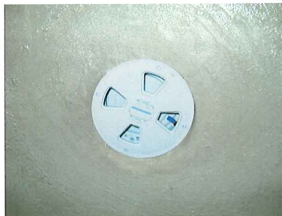
写真-3 消散弁設置状況
