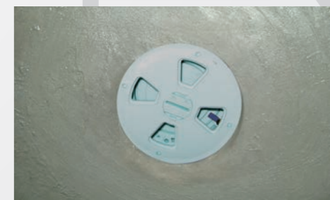
▲施工完了状況
