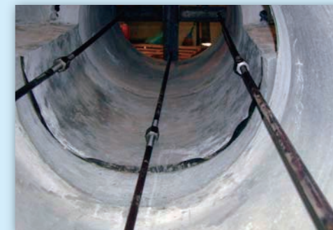
▲管の40mm突出し時の吸収ゴムブロックの確認 (ゴムの潰れによる衝撃の吸収緩和)
