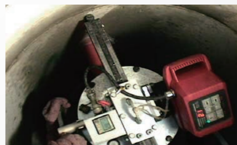
▲マンホール壁の削孔状況
