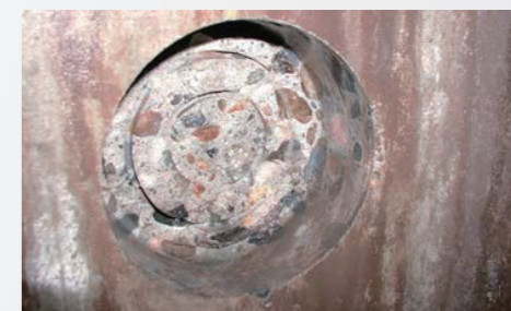
▲削孔完了状況
