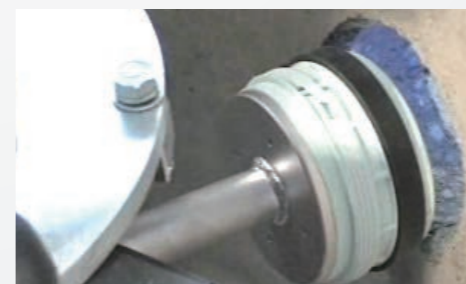
▲消散弁の圧入状況
