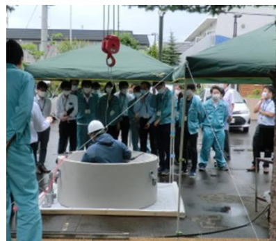
写真-2 デモ施工の様子
